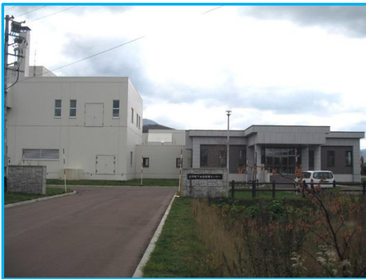
下水道管理センター
